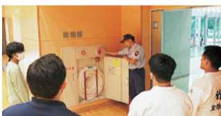
9号館2階・総合体育館メインアリーナに設置されている屋内消火栓で実演
